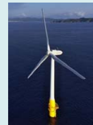
崎山沖2MW浮体式風車 「はえんかぜ」
