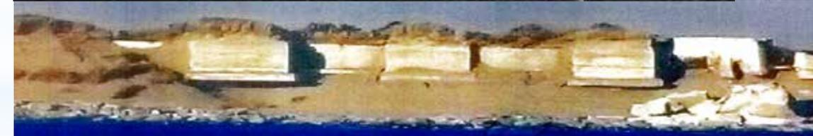
管理者である国交省が航路安全のために護岸の周囲を矢板で囲み、さらに緊急時利用のために陸上部を整地。
