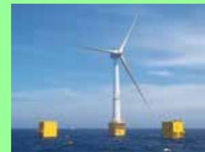
7MW浮体式風車
