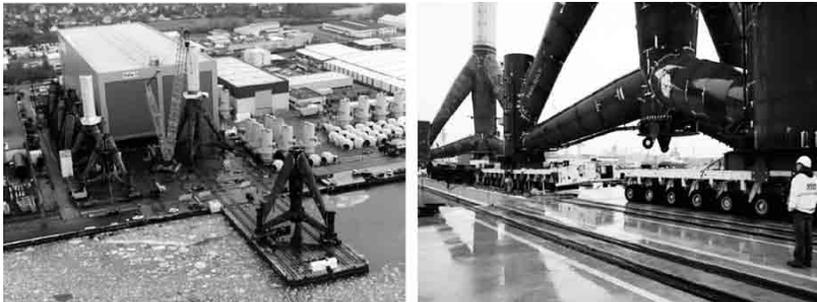
図9 トライポッド基礎の荷役と台船による運搬 (Bremenports, 2014)
