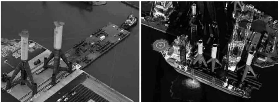
図 12 トライポッド基礎のレール荷役と設置船による積み出し (Bremenports, 2014)
